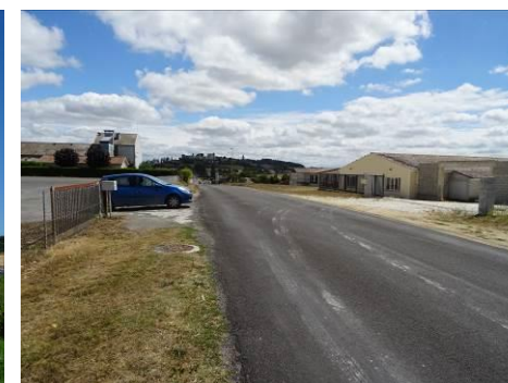
Villebois-Lavalette – Entrée nord par RD23
