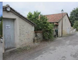
Ancien presbytère, Chavenat
