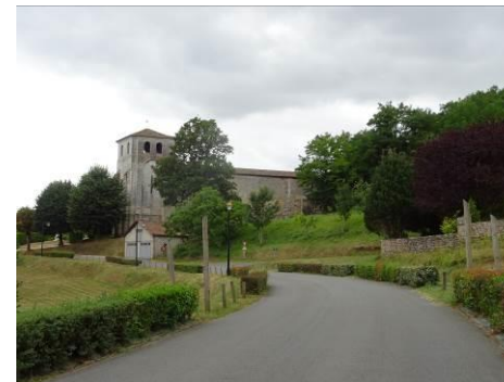
Rougnac – Entrée nord-est par RD 16
