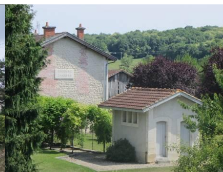
L'ancienne gare de Rougnac
