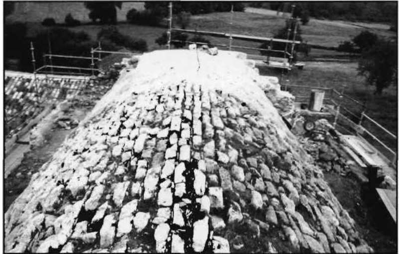
Extrados de la voûte de la nef
