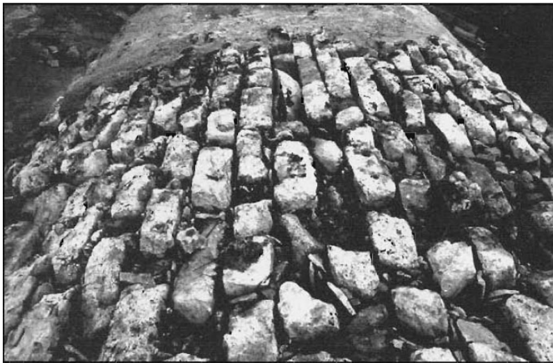
Détail de l'extrados
