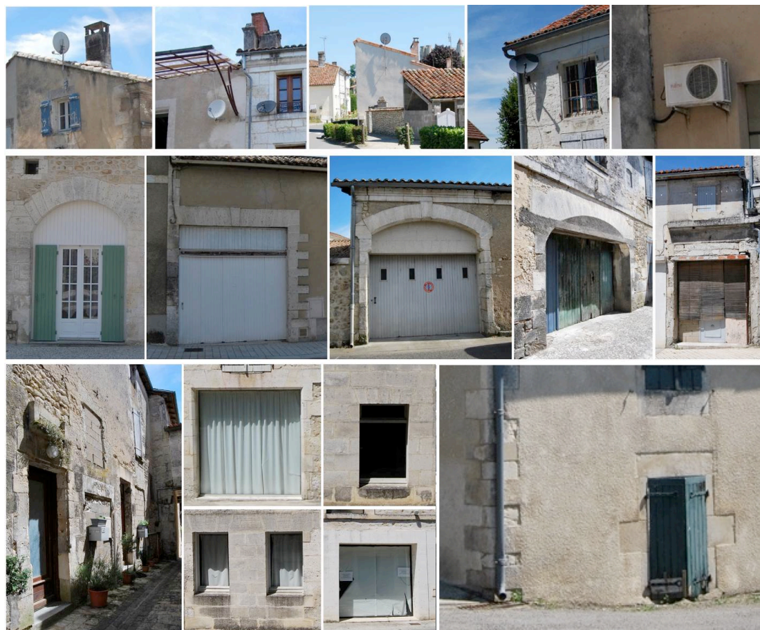
Illustration 31 : L'extrait du repérage des bâtiments dégradés de la ZPPAUP
