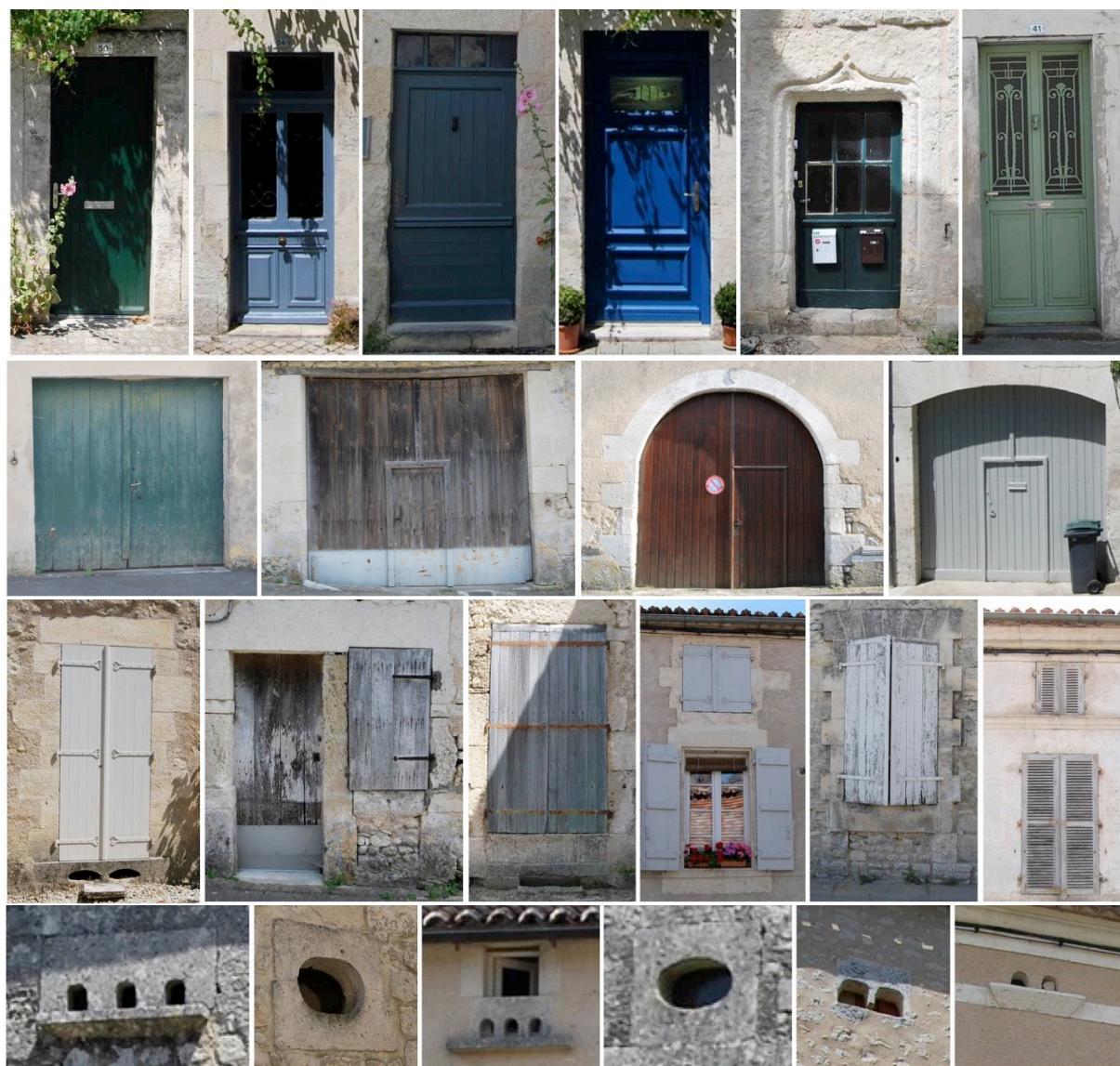
Illustration 36 : Repérage des portes, portails, des volets et des détails en pierres
