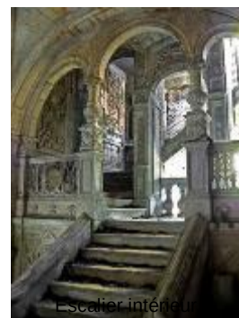
Escalier intérieur encore visible
