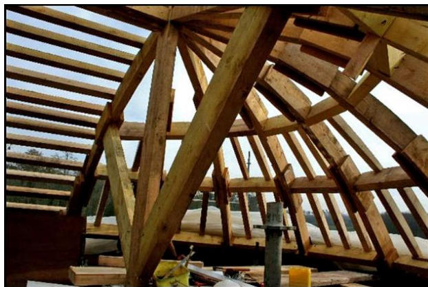
Construction de la charpente 13 avril 2008
