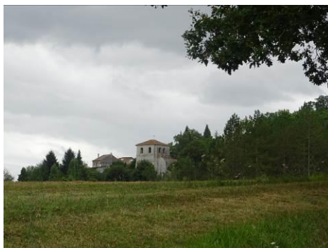
Eglise de Rougnac
