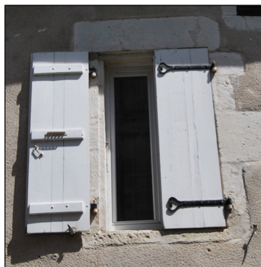
Contrevents en bois pour se protéger des éléments extérieurs (vents, soleil, pluie,...)
