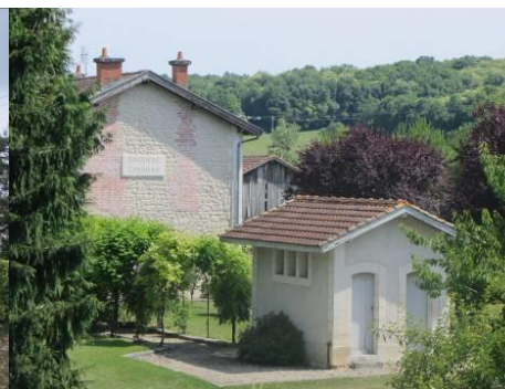
L'ancienne gare de Rougnac
